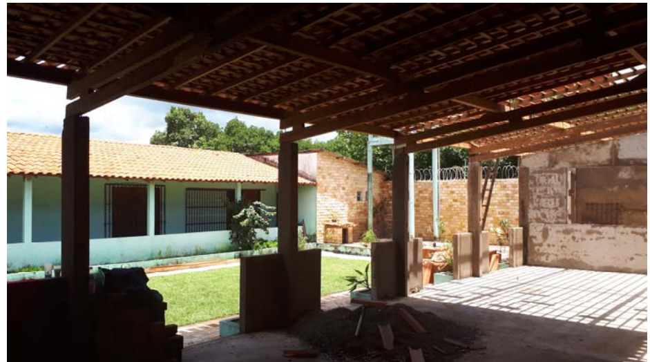
De salão Celestial in Raposa (MA) in aanbouw
